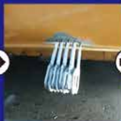
②『ダブルホールワッシャー』を損傷部に溶植
