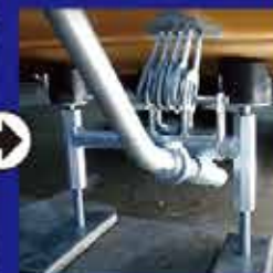
④ワッシャーに専用クランプを接続し、レバーで引出します
